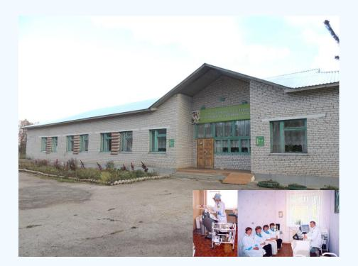
Проблема – здание 1986 года постройки, износ которого составляет более 70%, на стенах местами осыпалась штукатурка, неплотный притвор дверей, оконные рамы разрушены, деформированы, внутренняя отделка покрытие полов изношены
